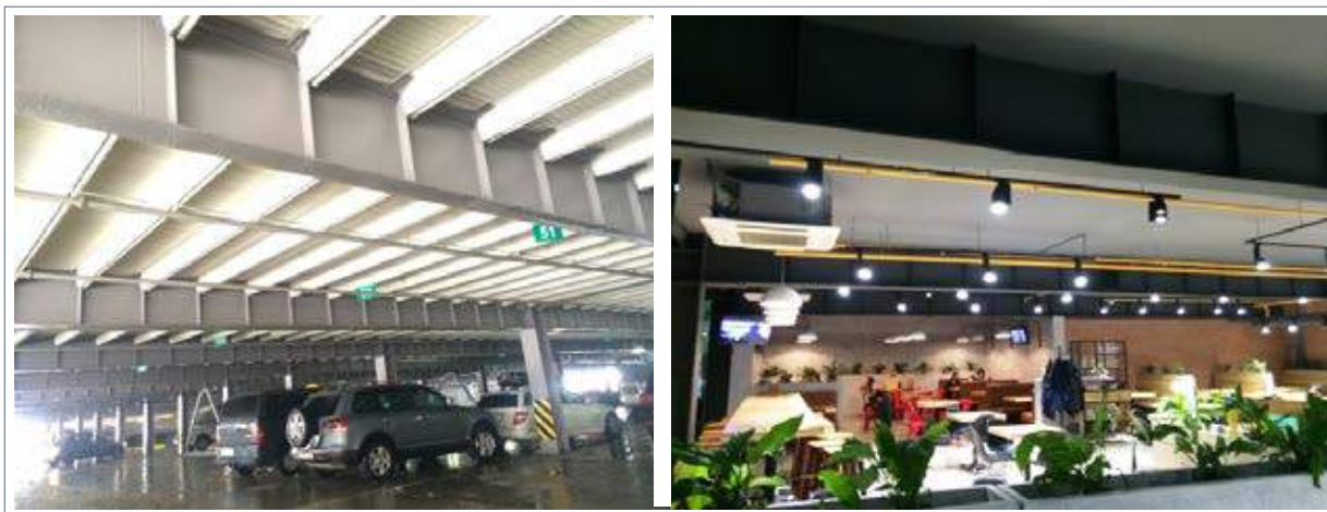
Рис. 2.23. Перепланування частини діючої багатоповерхової автостоянки зі сталевими композитними балками і плитами по профнастилу під ресторан завдяки реалізації великопролітного безколонного планування (Буковель, Україна)
