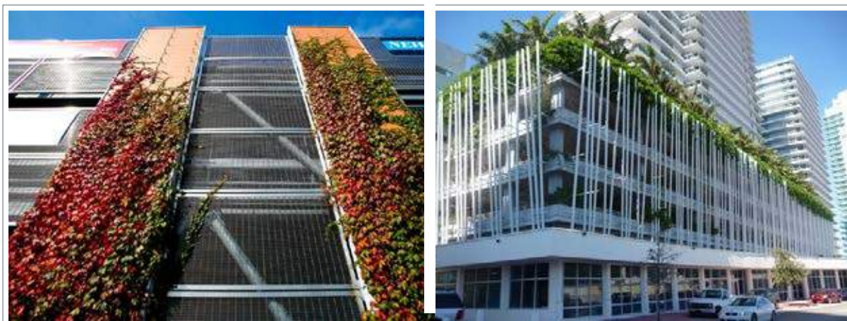
Рис. 2.24. Озеленення фасадних конструкцій ASDA Weymouth Multistorey Car (ВБ); реновація існуючої багатоповерхової автостоянки «Araneta Center» (Філіпіни) із улаштуванням фасадного озеленення і зеленої покрівлі
