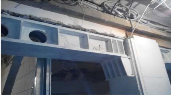
→ **Перфорированные балки усиления из высокопрочной стали (с440)**
