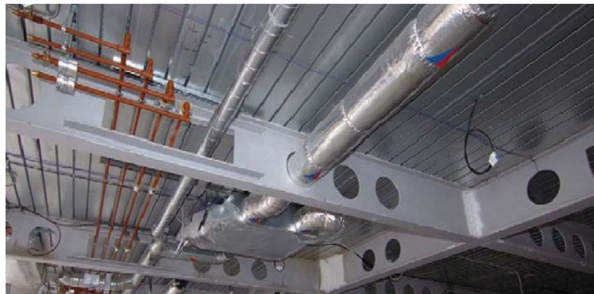
Обеспечение композитной, совместной работы стальной балки и железобетонной плиты настила позволяет снизить металлоемкость, уменьшить строительную высоту и повысить жесткость каркаса. Также возрастает устойчивость перекрытия к огню и вибраций.
