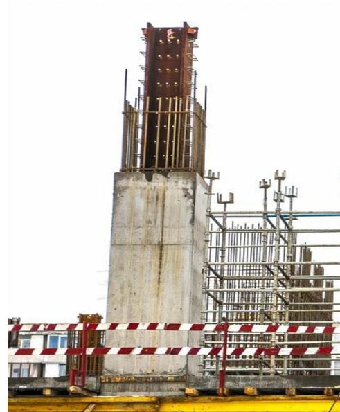
Сталежелезобетонные колонны МФК Sky Towers, в которых бетон выполняет несущую и пожарозащитную функции.
