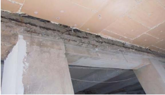
→ **Коррозионное повреждение железобетонного ригеля 8-этажного здания (ул. Крещатик, 29/1, Киев, Украина)**
