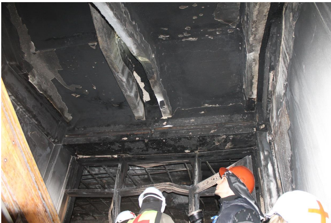
Кіптява на конструкціях, відлущення тиньку
