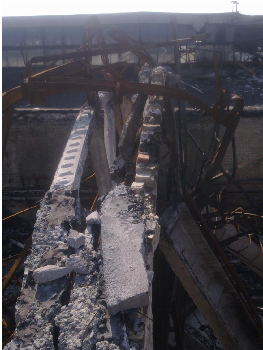
Вихід із площини ферми покриття та цегляної стіни між приміщеннями
