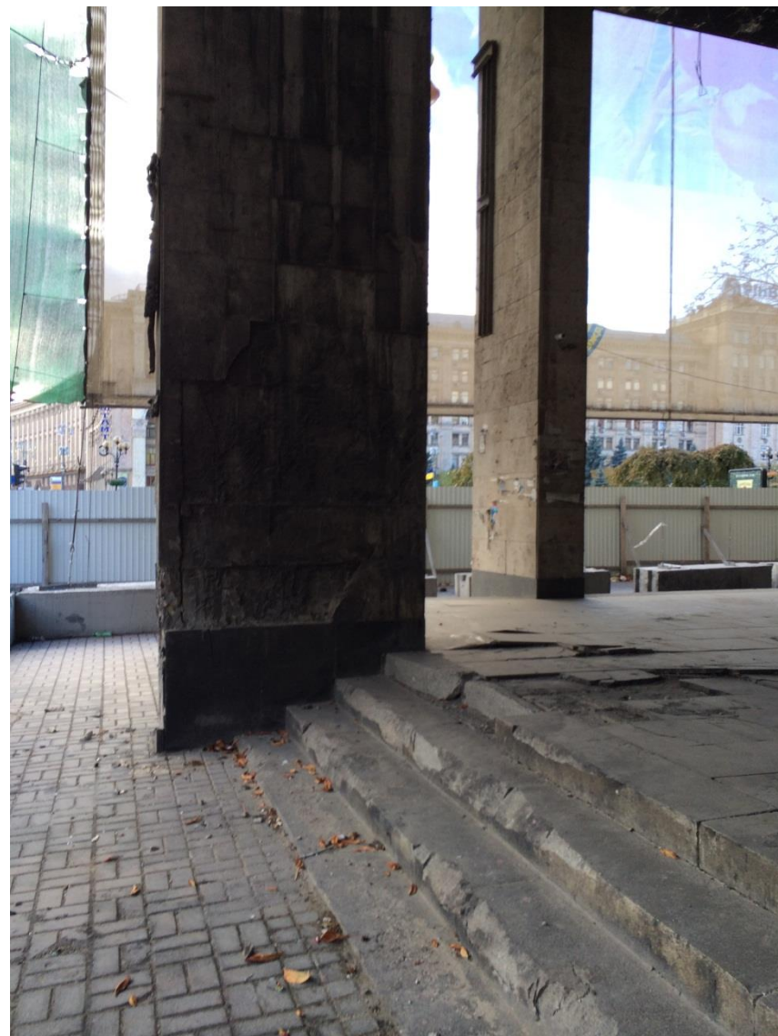
Фасадні колони і колони всередині будівлі – майже не постраждали внаслідок конструктивного вогнезахисту
