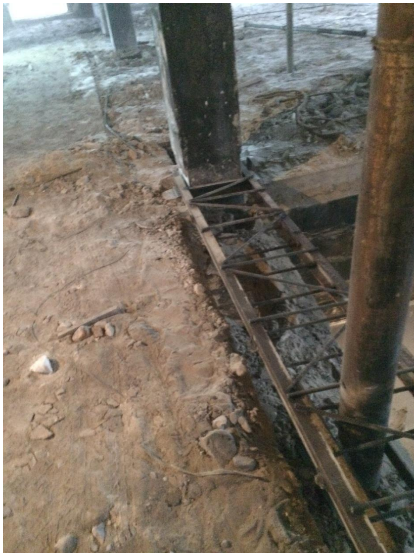
Підкріплення колон з метою зменшення розрахункової довжини
