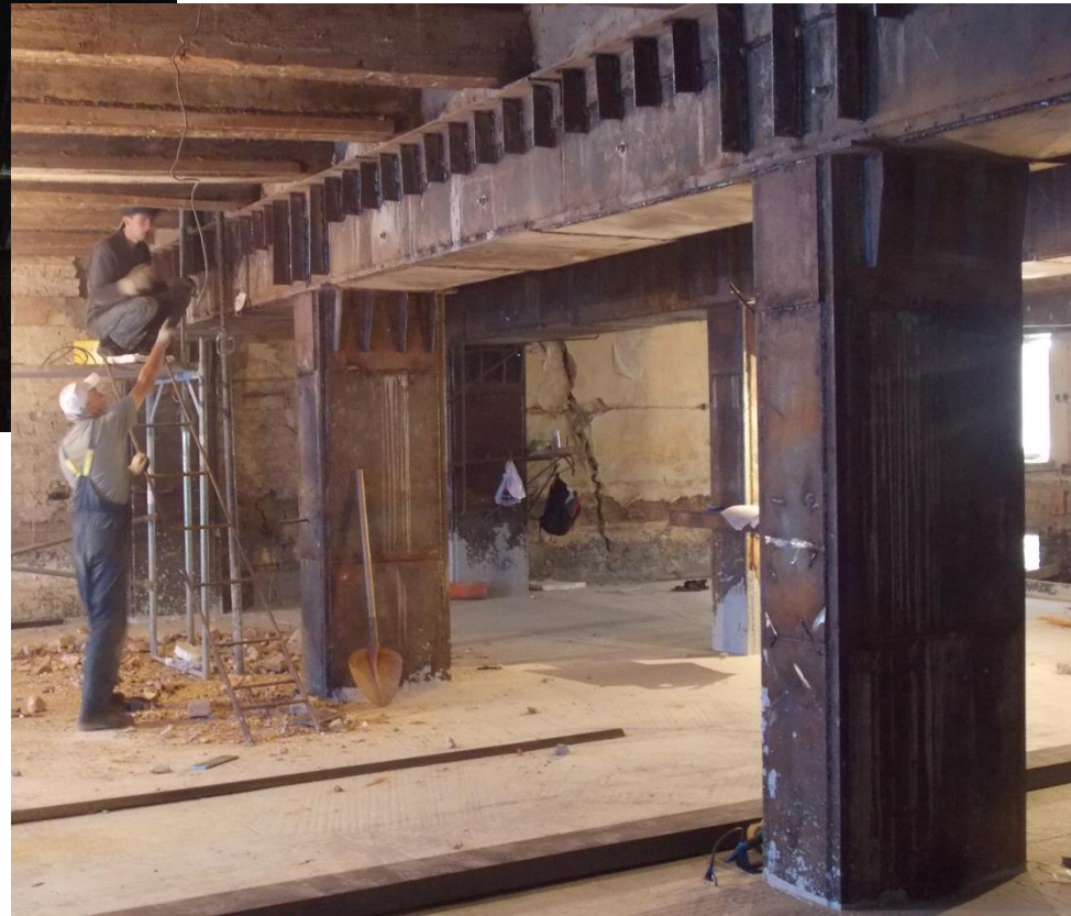
Заповнення бетоном колон
