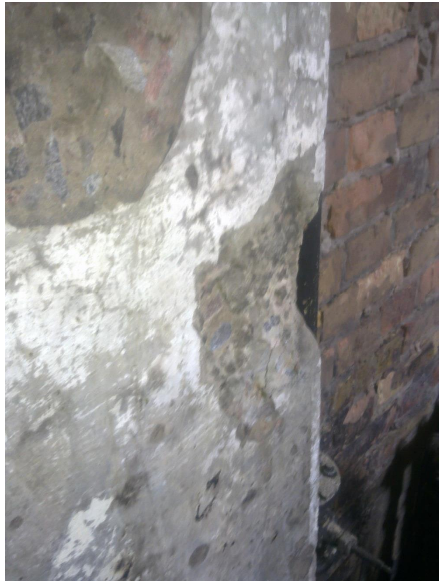
Розтріскування, відлущення захисного шару, несучої залізобетонної колони внаслідок дії вогню
