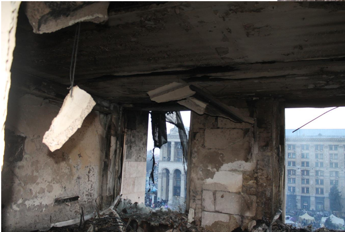
Поздовжні тріщини, випадіння нижніх поличок та армування
