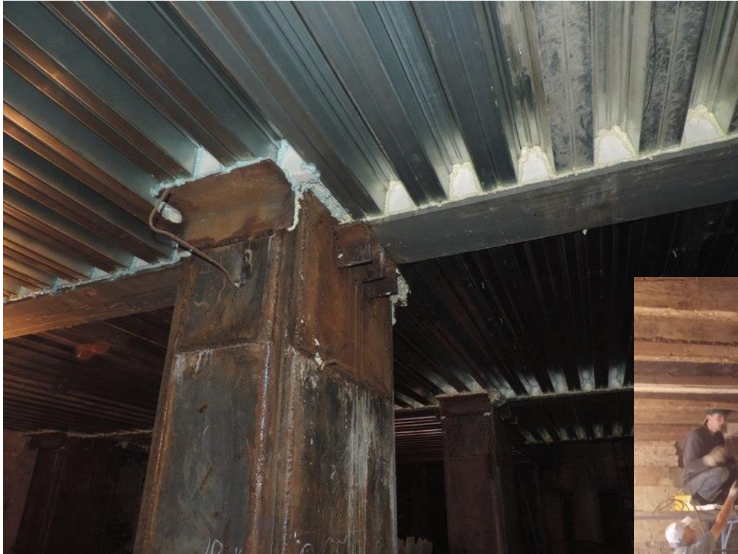
Заповнення бетоном колон
