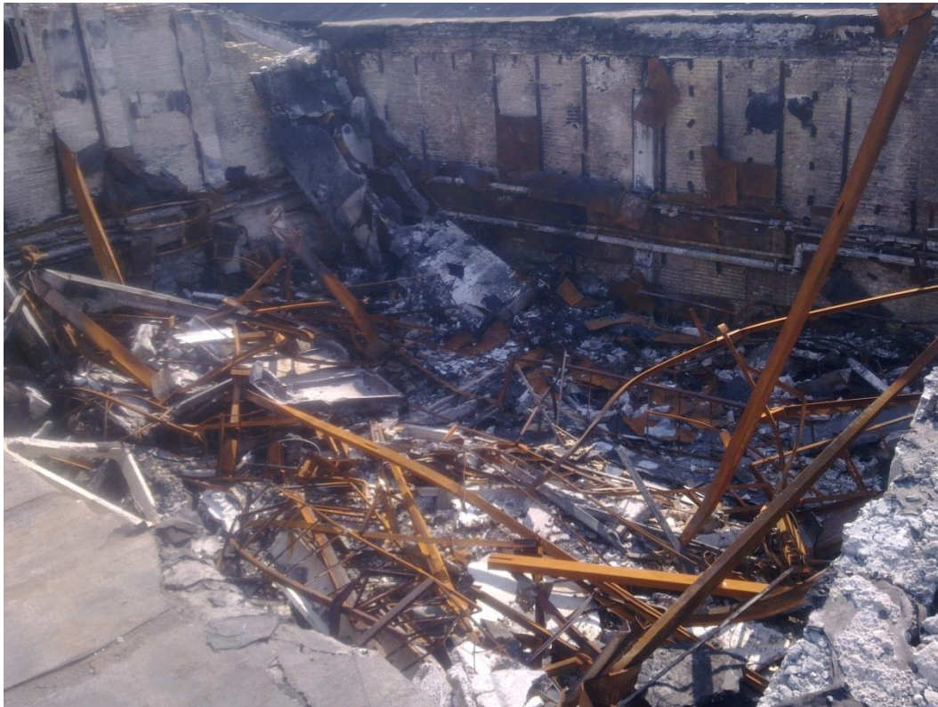
Цілковите обвалення конструкцій покрівлі
