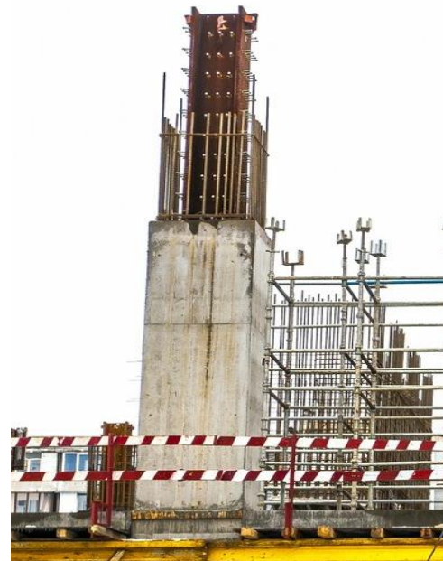
Сталезалізобетонні колони МФК Sky Towers, у яких бетон виконує несучу та пожежозахисну функції
