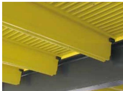
Наиболее высокие специальные настилы для сталежелезобетонных перекрытий
