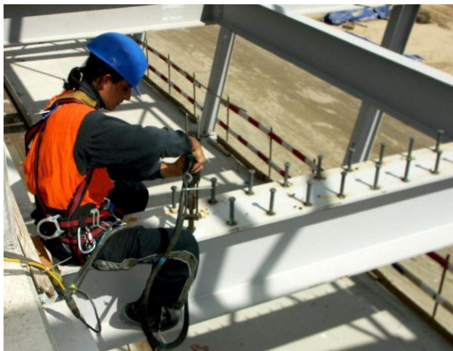
Контактная сварка
