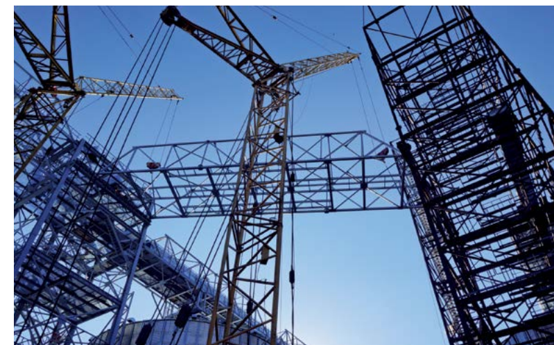
□ Монтаж транспортной галереи весом 15 т в стесненных условиях (+45 м)
