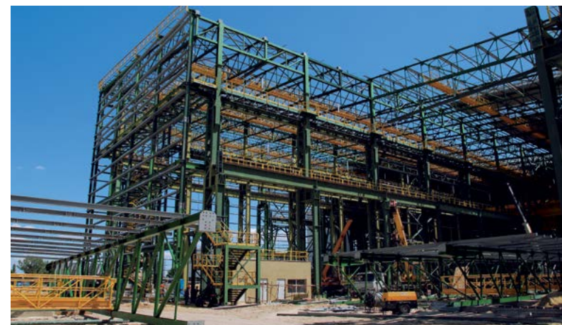
Вес металлоконструкций – 4 500 т
