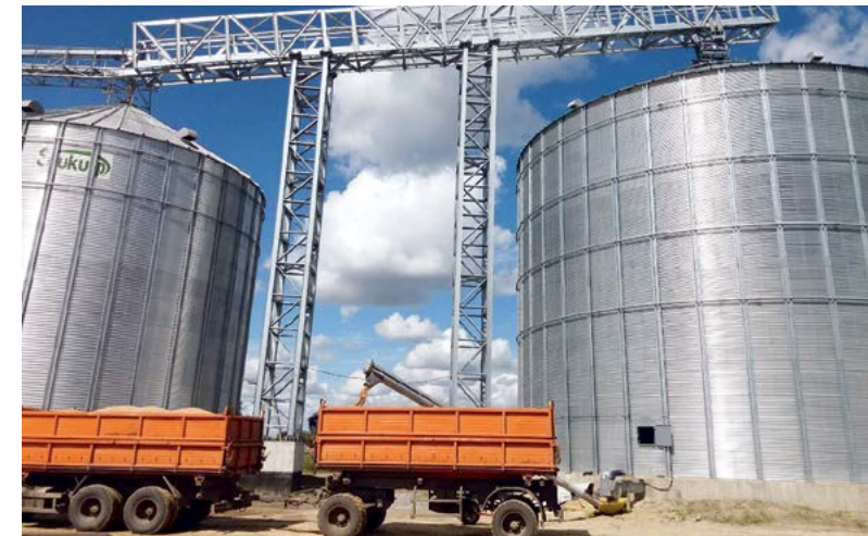
□ Каркас переходной галереи, Сумская обл., Украина
