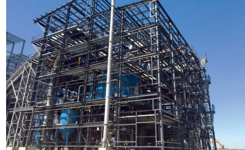
Цех маслоэкстракционного завода, Тернопольская обл., Украина
