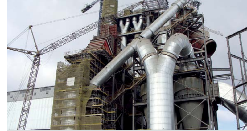
Монтаж металлоконструкций каркасов этажерок – 1 900 т газохранилищ – 1 530 т и оборудования – 1 380 т
