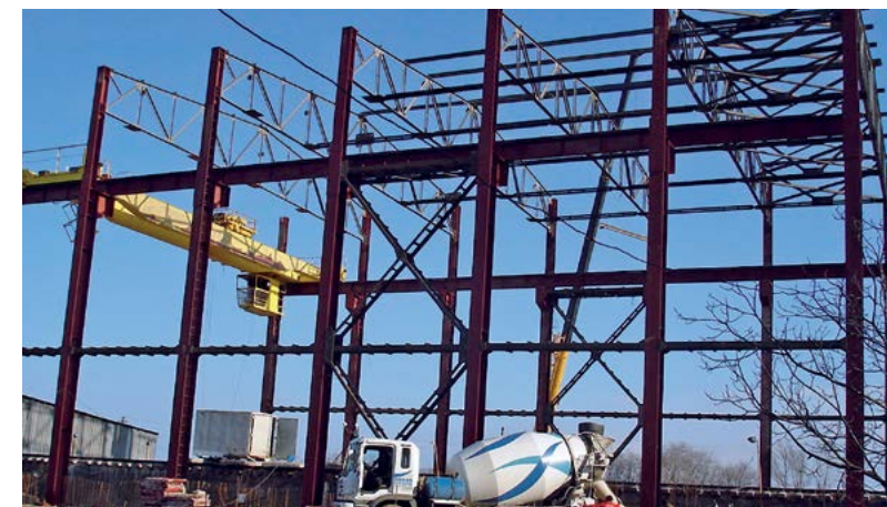
Вес металлоконструкций – 120 т
