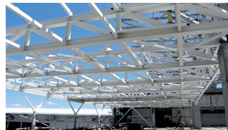
Вес металлоконструкций – 375 т
