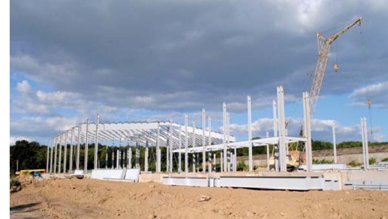
Вес металлоконструкций – 263 т
