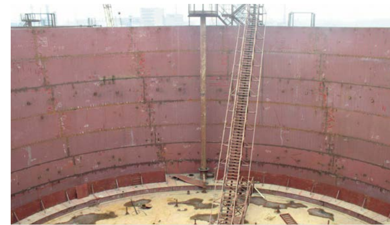
Монтаж резервуара РВС 25 000 куб. м
