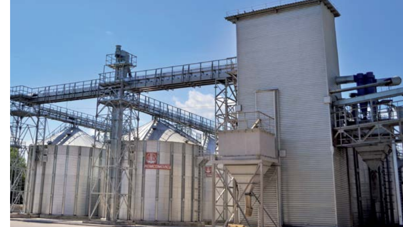
Вес металлоконструкций – 325 т
