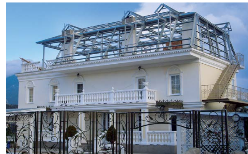
□ Надстройка жилого дома из ЛСТК, г. Ялта, Украина
