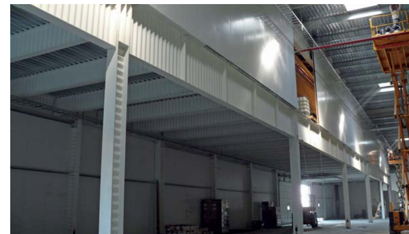
Вес металлоконструкций – 1 550 т
