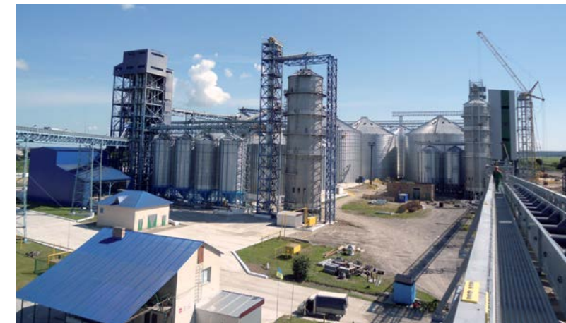
Монтаж металлоконструкций, опор, галерей, оборудования
