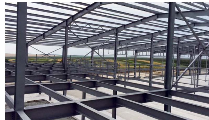
Вес металлоконструкций – 420 т
