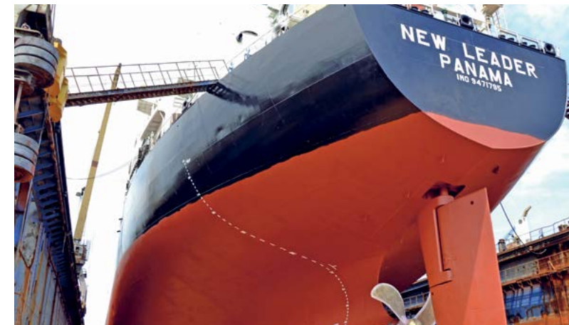
Нанесение защитных покрытий на наружный корпус т/х NEW LEADER
