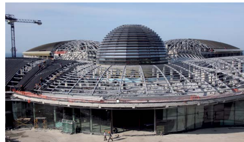
Вес металлоконструкций – 400 т
