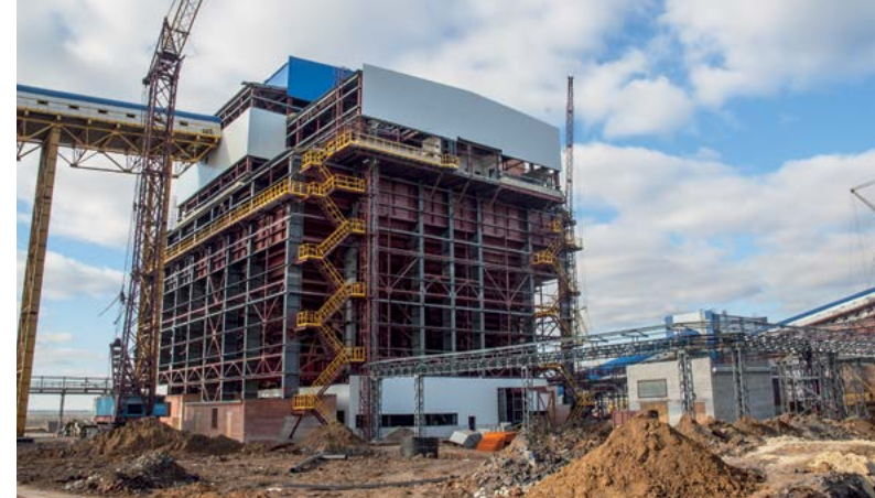
Вес металлоконструкций – 5 500 т
