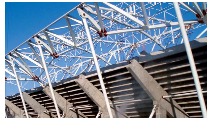
Вес металлоконструкций покрытия – 1 300 т
