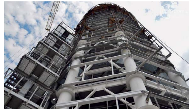
Вес металлоконструкций – 500 т
