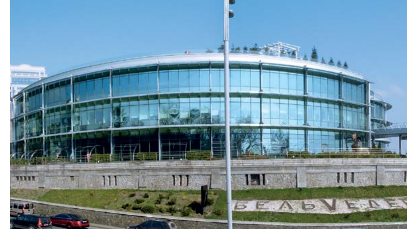
Вес металлоконструкций – 424 т
