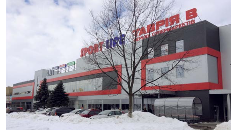
Вес металлоконструкций – 400 т
