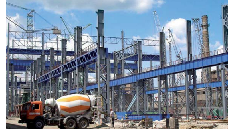
Вес металлоконструкций – 8 000 т
