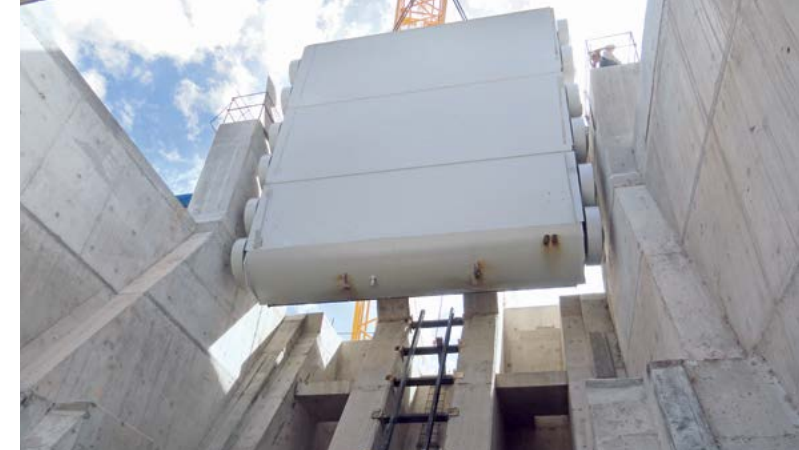
Изготовление и монтаж гидромеханического оборудования – 4 200 т
