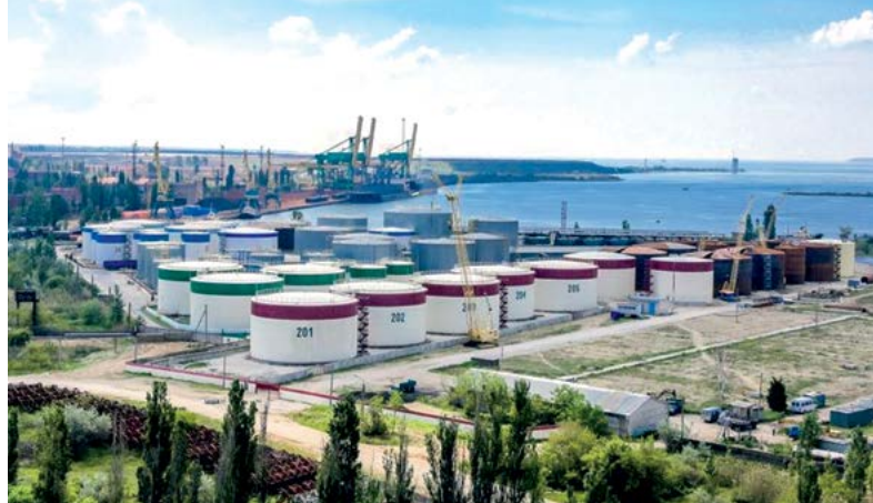
Окраска резервуарного парка для хранения растительного масла
