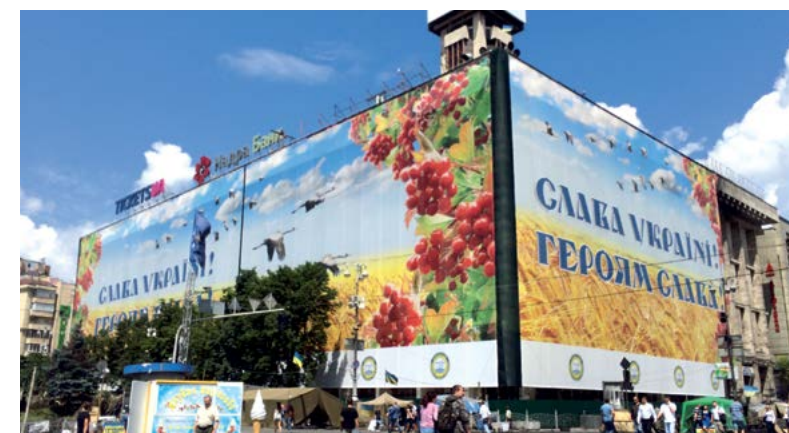
Обследование после пожара, генпроектирование, сопровождение, 2014-2016 годы
