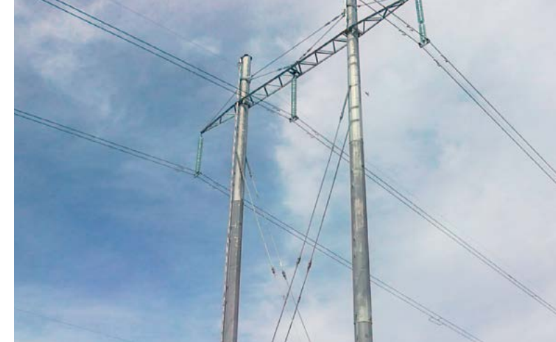
□ Опора ПМГ330-28, Укрэнерго, Украина
