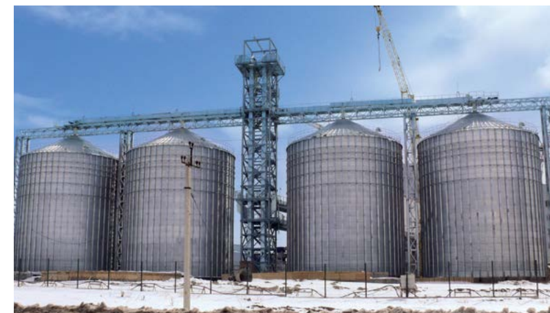
Вес металлоконструкций – 3 300 т
