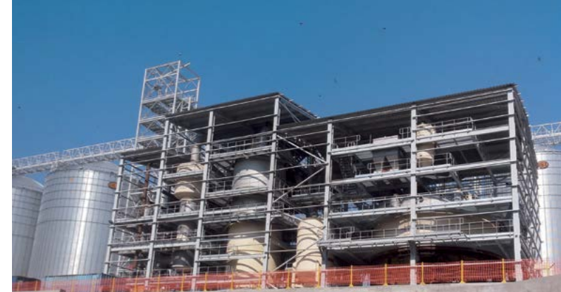
Вес металлоконструкций – 2 500 т
