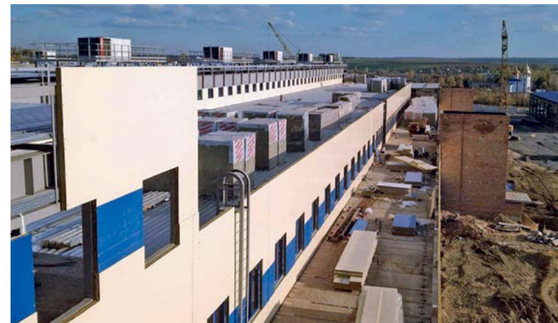
Вес металлоконструкций – 3 500 т
