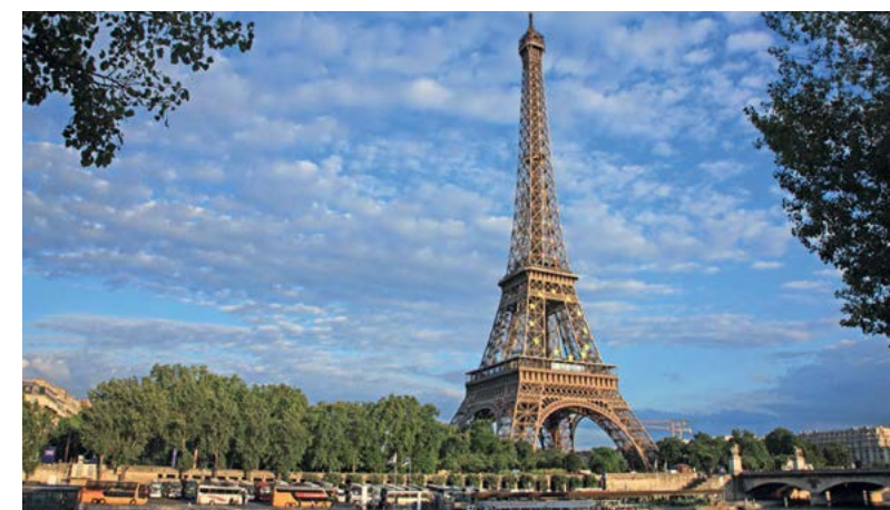
Антикоррозионная защита металлоконструкций, выкрашено 50 000 л.
