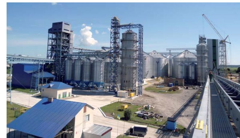
Монтаж металлоконструкций, опор, галерей, оборудования
