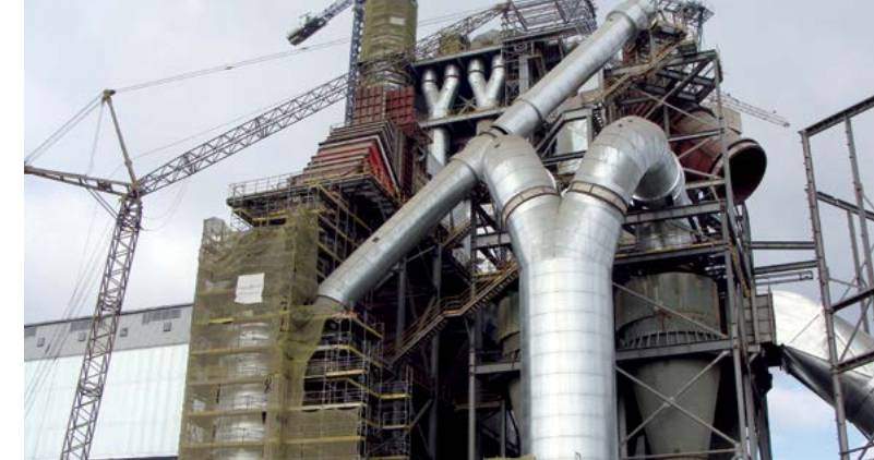
Монтаж металлоконструкций каркасов этажерок – 1 900 т газоходов – 1 530 т и оборудования – 1 380 т
