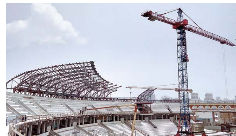
Окраска 3 500 т металлоконструкций
