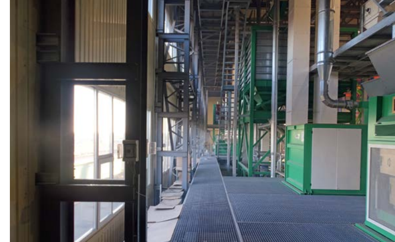
□ Перекрытие внутри производственного цеха
