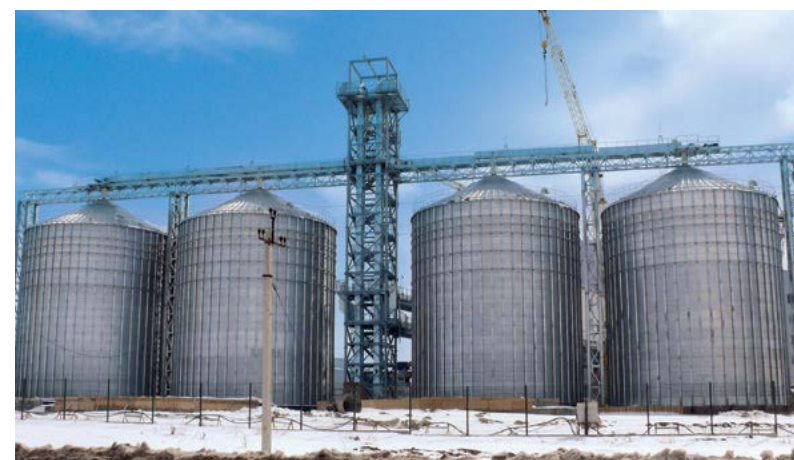
Вес металлоконструкций – 3 300 т
