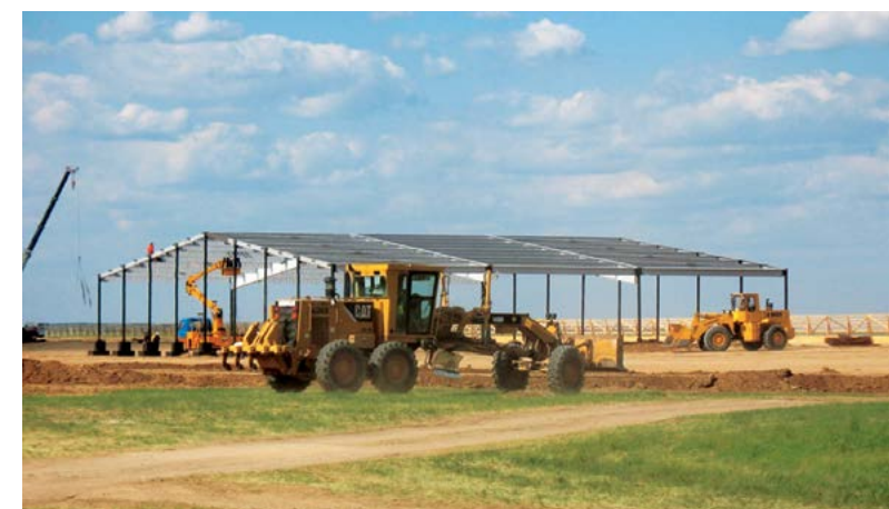
Вес металлоконструкций – 555 т
