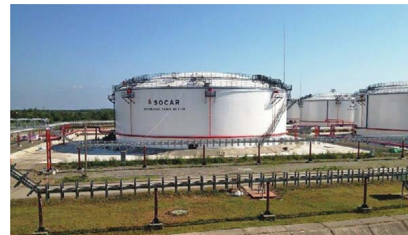
Окраска поверхностей резервуаров для нефтепродуктов
