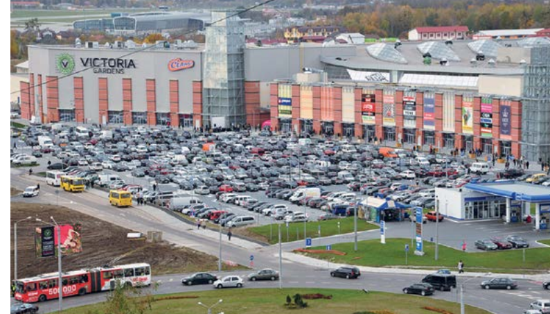
Вес металлоконструкций – 950 т
