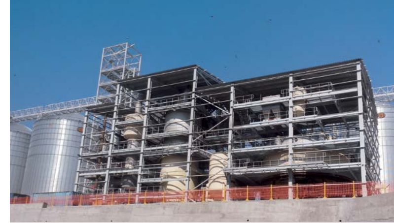
Вес металлоконструкций – 2 500 т
