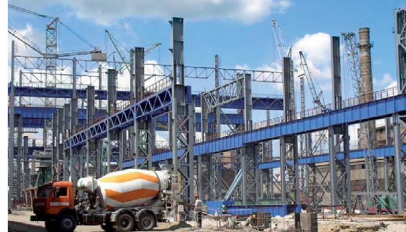
Вес металлоконструкций – 8 000 т
