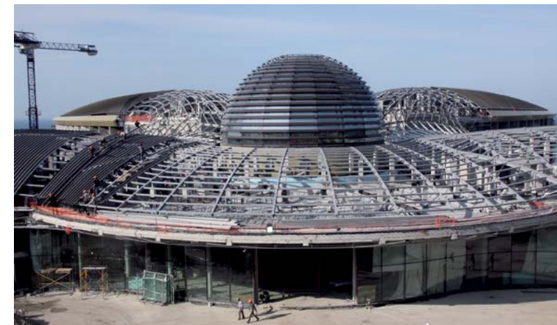
Вес металлоконструкций – 400 т
