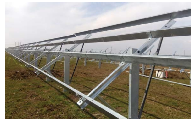
□ Опорная наземная конструкция для фотогальванических модулей, Украина
