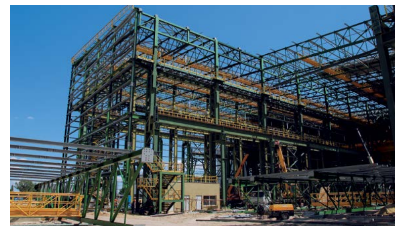
Вес металлоконструкций – 4 500 т
