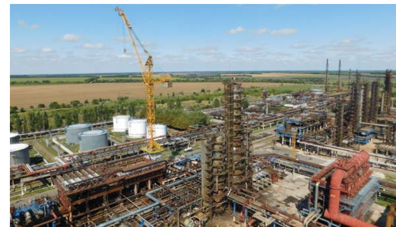
Обследование и паспортизация зданий и сооружений, 2013-2017 годы
