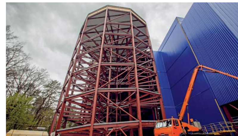
Вес металлоконструкций – 3 000 т
