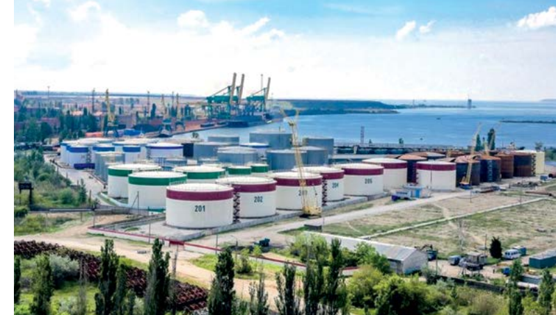
Окраска резервуарного парка для хранения растительного масла
