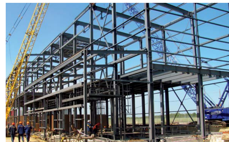
□ Когенерационная установка завода Кока-Кола, Киевская обл., Украина
