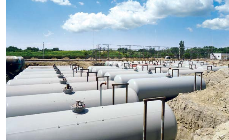
□ Резервуары хранения Эконоватика, г. Измаил, Украина
