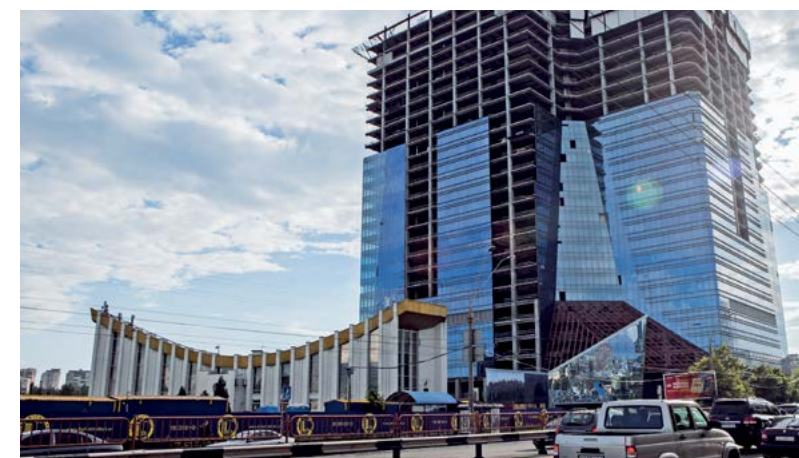
Вес металлоконструкций – 4 000 т
