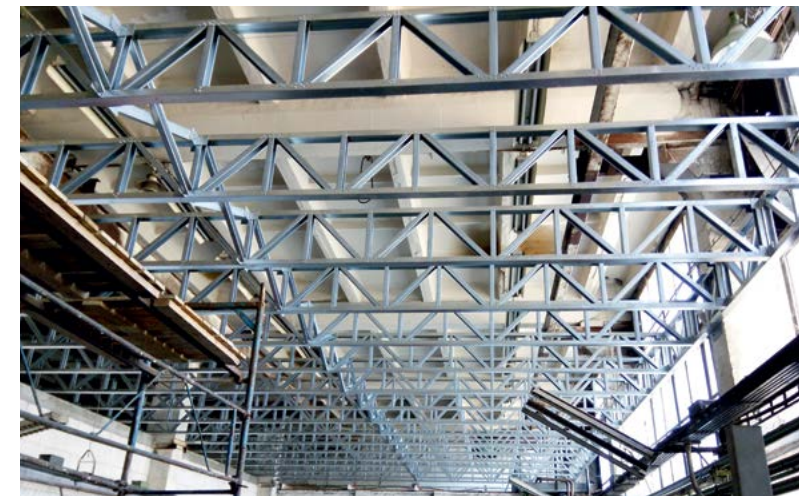
□ Конструкция подвесного потолка складского помещения, г. Черкассы, Украина
