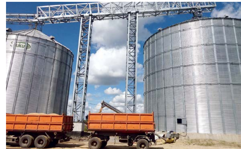
□ Каркас переходной галереи, Сумская обл., Украина
