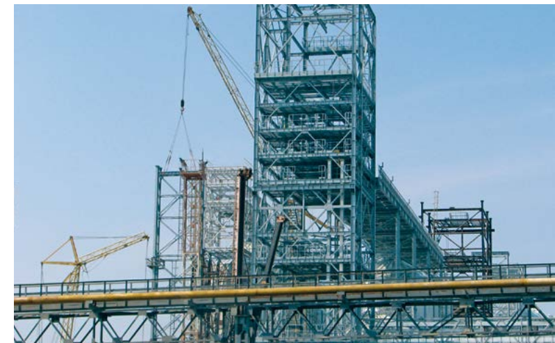
□ Монтаж металлоконструкций, h=62 м
