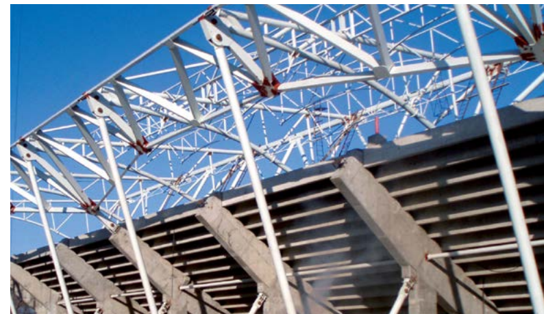
Вес металлоконструкций покрытия – 1 300 т
