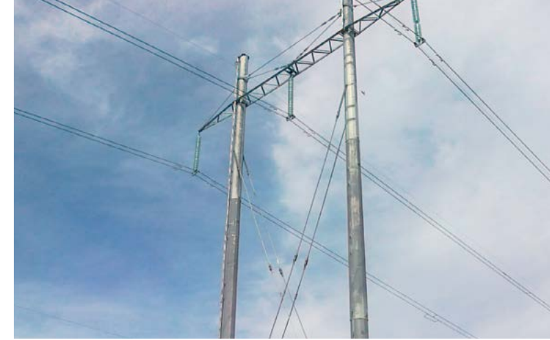
□ Опора ПМГ330-28, Укрэнерго, Украина
