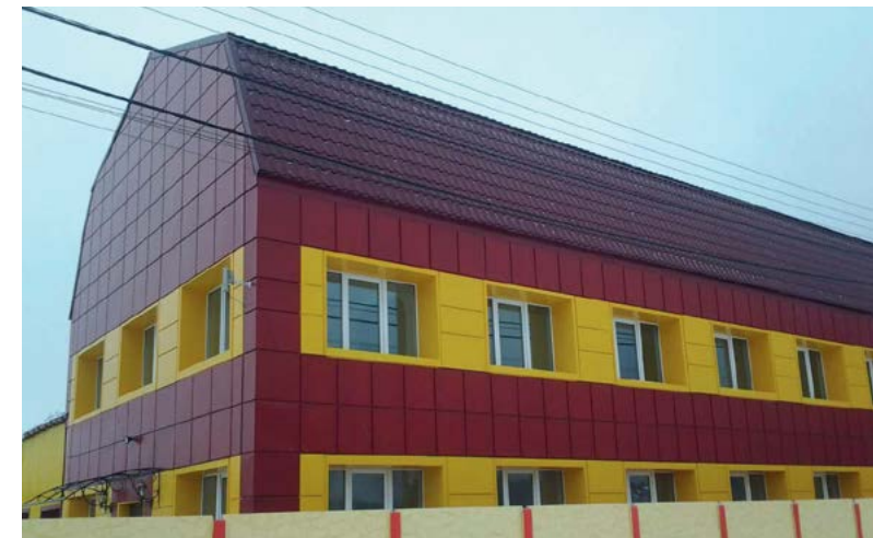
□ Устройство вентилируемого фасада, с. Старые Петровцы, Украина
