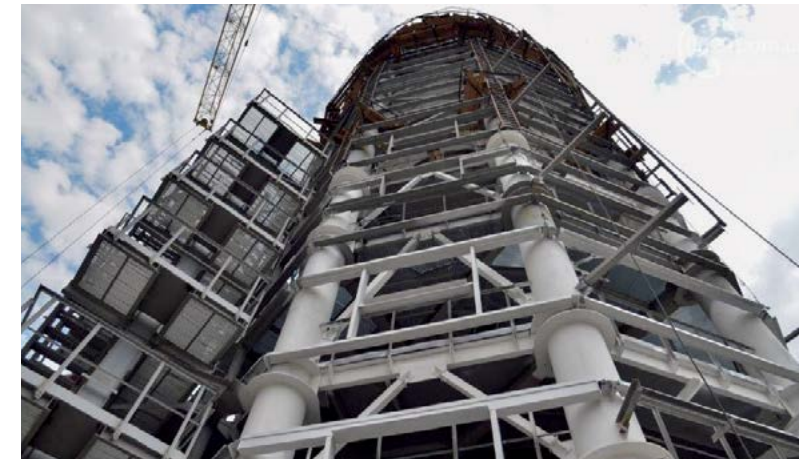
Вес металлоконструкций – 500 т
