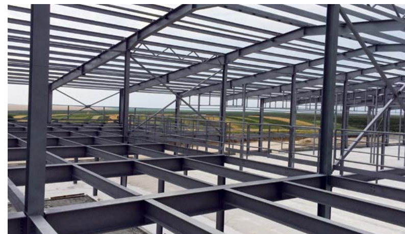
Вес металлоконструкций – 420 т
