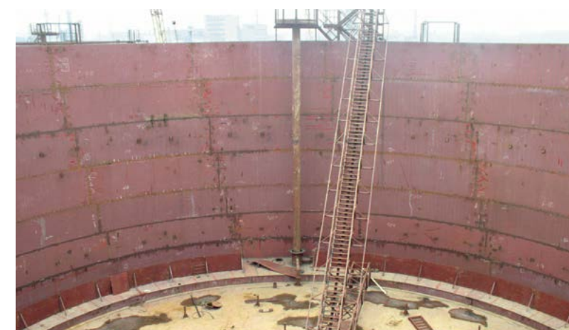
Монтаж резервуара РВС 25 000 куб. м
