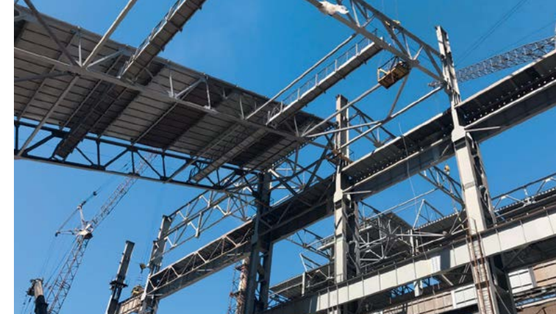
Антикоррозионная защита металлоконструкций 130 000 кв. м
