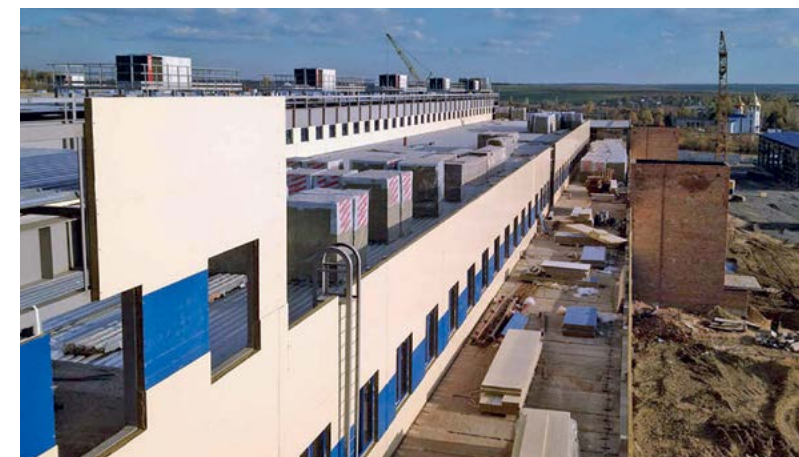
Вес металлоконструкций – 3 500 т
