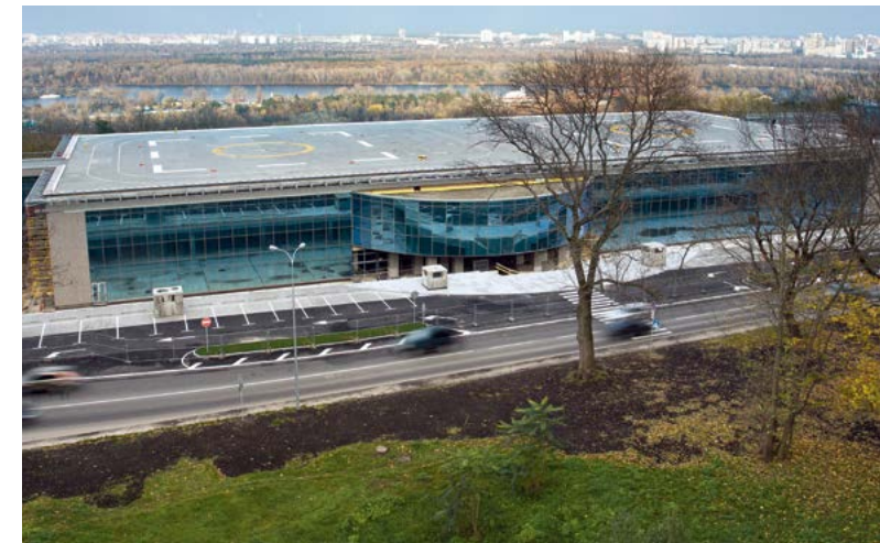
□ Вертолетная площадка с прилегающей эстакадой, г. Киев, Украина
