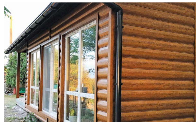
□ Фасад из металлического сайдинга, Полтавская обл., Украина
