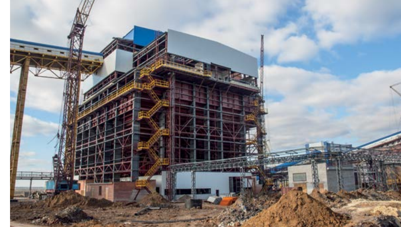
Вес металлоконструкций – 5 500 т
