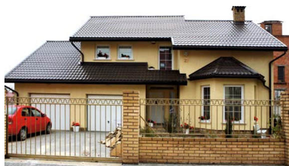
Частный жилой дом – пример применения металлочерепицы Ruukki Monterrey
