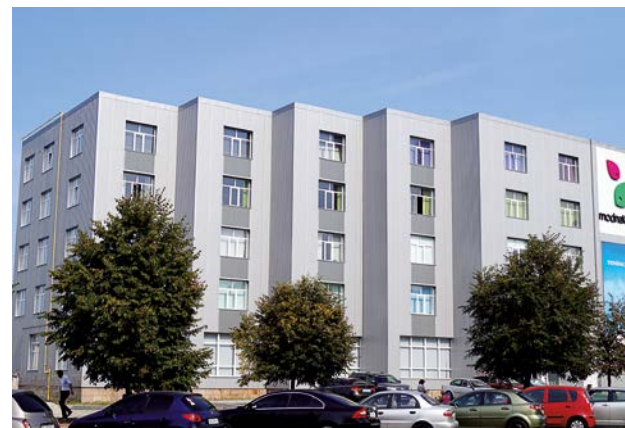
Офисное здание Модна Каста в г. Киеве – пример навесного фасада с профилированными листами, реализация – компания «Сталекс»
