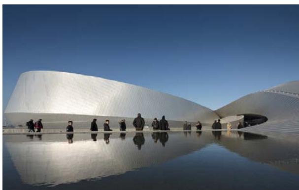
Аквариум «Голубая планета», Копенгаген, Дания. Дизайн - 3XN. Пример вентилируемого фасада на основе жестких термоизоляционных плит ROCKWOOL толщиной 200 мм и стальных фасадных кассет
