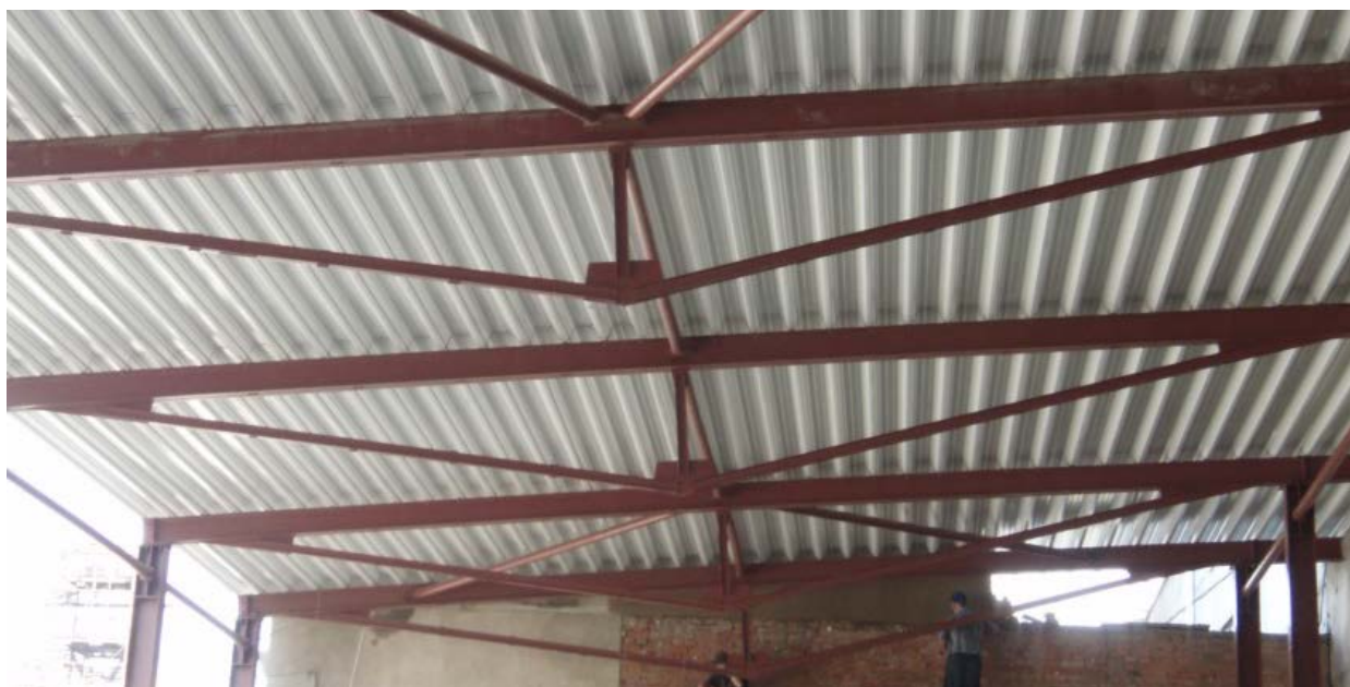
Профнастил Т135, смонтированный в беспрогонной схеме кровли на пролете 6 м, реализация – компания «Прушиньски»
