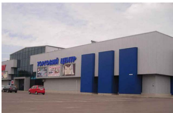
Торговый центр «Ювант», г. Ковель – ВСК с облицовочной профнастилом, реализация – компания ТПК
