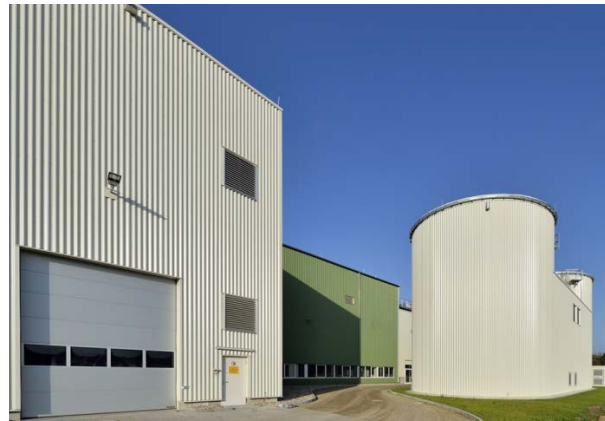
Производственный цех в Люнебурге, Германия (Lünnewell GmbH) – пример облицовки фасада стеновыми профилированными листами «идеальная волна»
