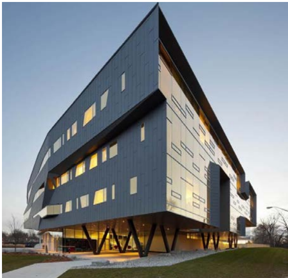
Stephen Hawking Centre at the Perimeter Institute for Theoretical Physics, Канада – пример навесного фасада здания с использованием навесных металлических панелей
