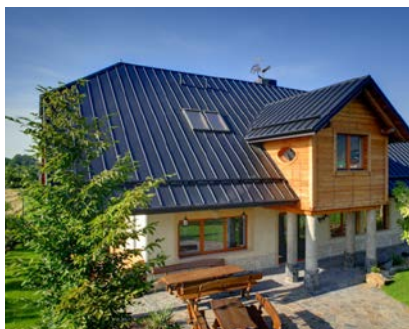
Частный жилой дом – пример фальцевой кровли Retroline, «Прушиньски»
