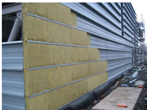
ВСК с утеплителем, реализация – компания «Прушиньски»
