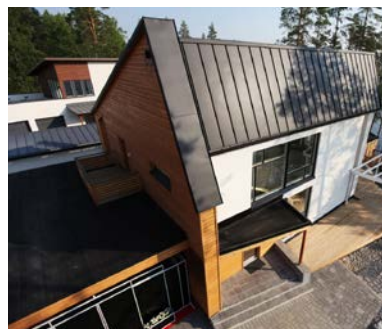
Частный жилой дом – пример применения кровельного покрытия Ruukki Classic
