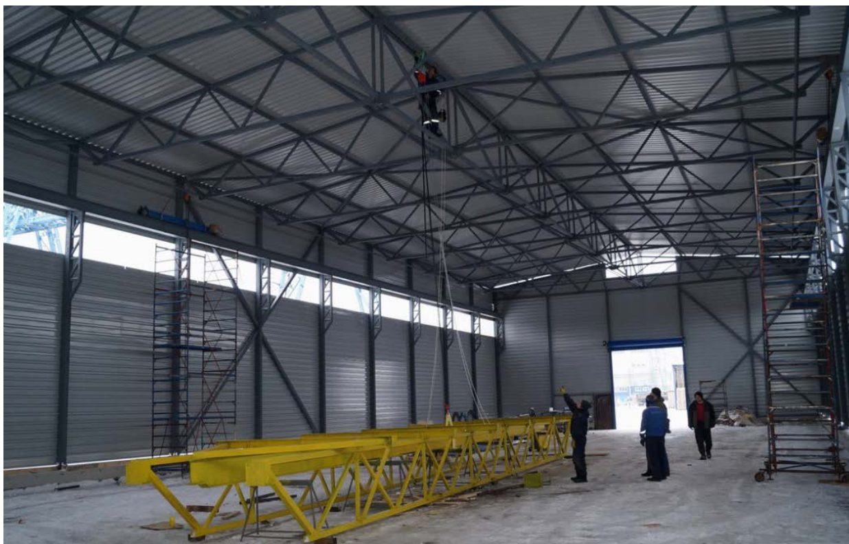
Конструкция «холодной» кровли
