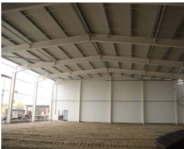
Применение Z-профиля в качестве прогонов покрытия
