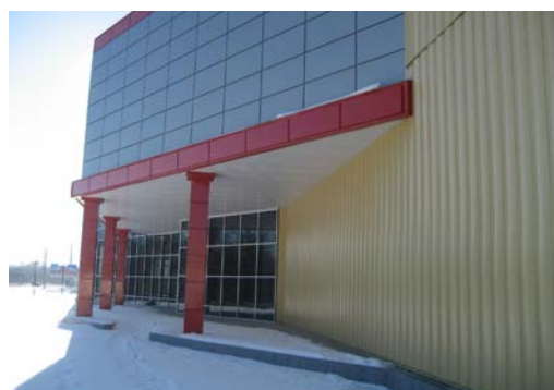
Пример применения на одном фасаде фасадных кассет и панелей на основе ВСК (Полтава)
