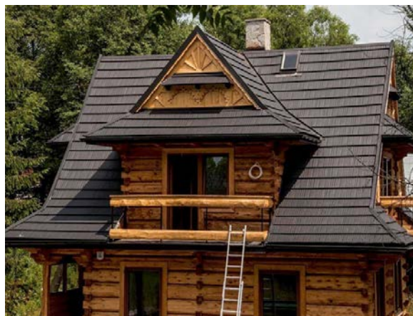
Частный жилой дом – пример исполнения кровли из металлочерепицы Karpatia, «Прушиньски»
