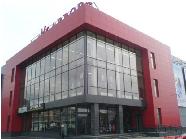
ТРЦ Аврора, г. Краматорск, Донецкая область – вентилируемый фасад, реализация – компания «Прушиньски»
