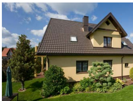
Частный жилой дом – пример применения металлочерепицы Ruukki Finnega
