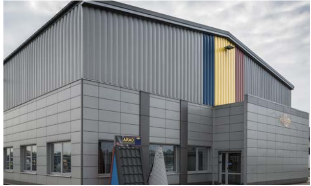
Производственный цех, Польша, пример навесной фасадной системы – облицовка фасадными кассетами и PS-панелями, реализация – компания «Прушиньски»
