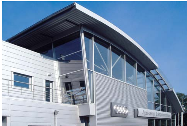
Audi-центр, г. Днепропетровск, Украина – пример применения профилированных листов и линейных систем для фасадов, реализация – компания Ruukki
