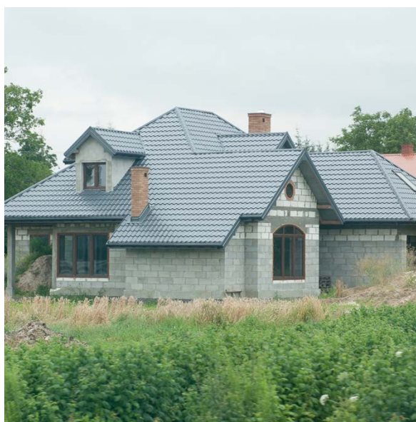
Пример скатной кровли
