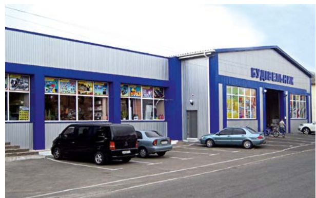
Применение профлистов «Сталекс» для фасада торгового здания в с. Вышеньки, Украина
