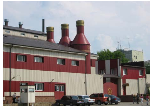
Производственное здание Олимп в г. Донецке – пример навесного фасада с профилированными листами, реализация – компания Ruukki
