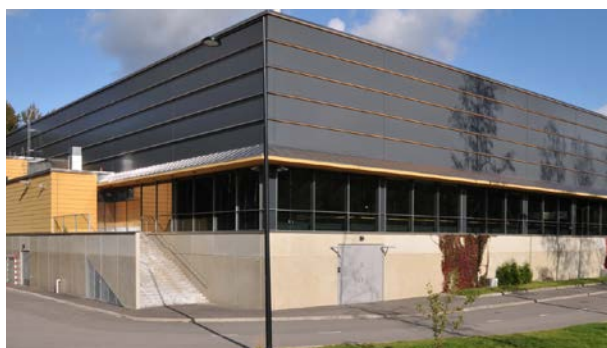
Спортивно-развлекательный комплекс Energia Areena, Финляндия – фасадная линейная система Lamella, реализация – компания Ruukki
