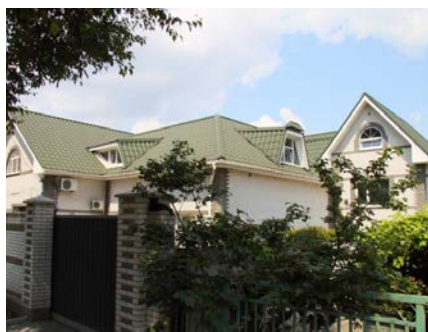
Частный жилой дом, г. Запорожье – пример кровли с покрытием из металлочерепицы ТПК
