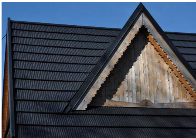
Частный жилой дом – пример исполнения кровли из металлочерепицы Karpatia, «Прушиньски»
