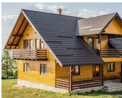
Пример исполнения кровли из металлочерепицы, «Прушиньски»
