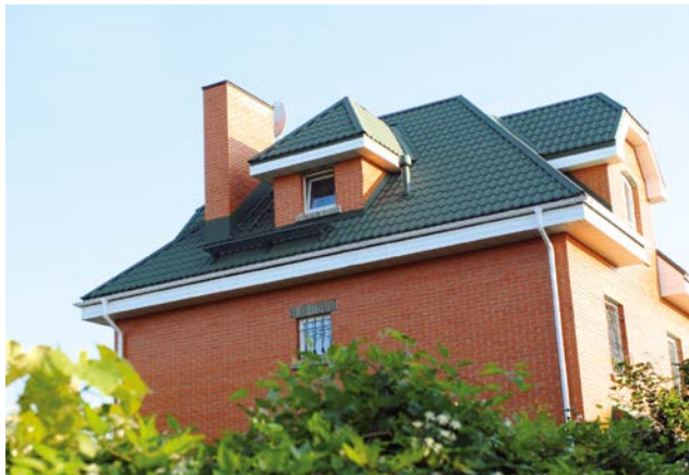
Частный жилой дом – пример исполнения кровли из металлочерепицы
