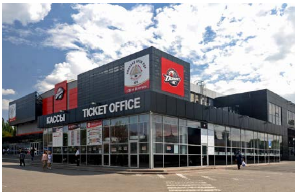
Дворец Спорта, г. Донецк, Украина, пример фасадной системы – облицовка перфорированными кассетами, реализация – компания «Прушиньски»
