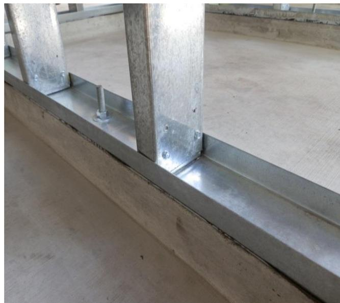
1. Стойки стеновой панели; 2. Направляющий (опорный) профиль стеновой панели;
